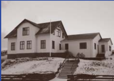
Aðalgötu 7 Byggingarár 1896 Byggt fyrir Davið Sch. Thorsteinsson Læknishús, Sýsluskrifstofa- & Íbúðarhús
