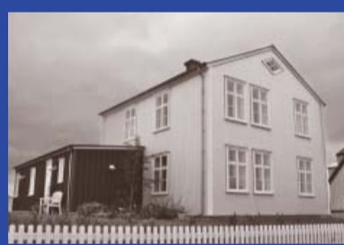
Sífurgata 6 Byggingarár 1895 Yfirmiður: Magnús Pórarinsson Byggt fyrir Séra Sigurð Gunnarsson Íbúðarhús
