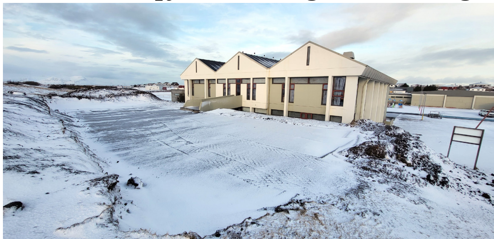
Búið er að undirbúa jarðveg fyrir nýju kennslurým.
