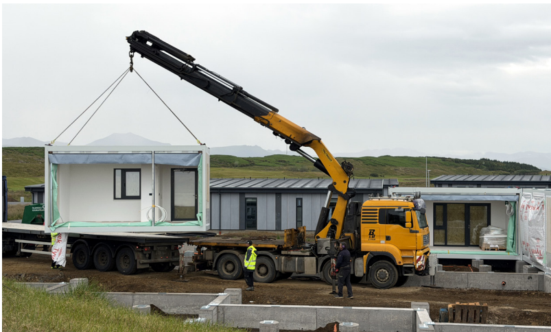
Einingar Stólpa ehf. hífðar á sinn stað í Víkurhverfi.
