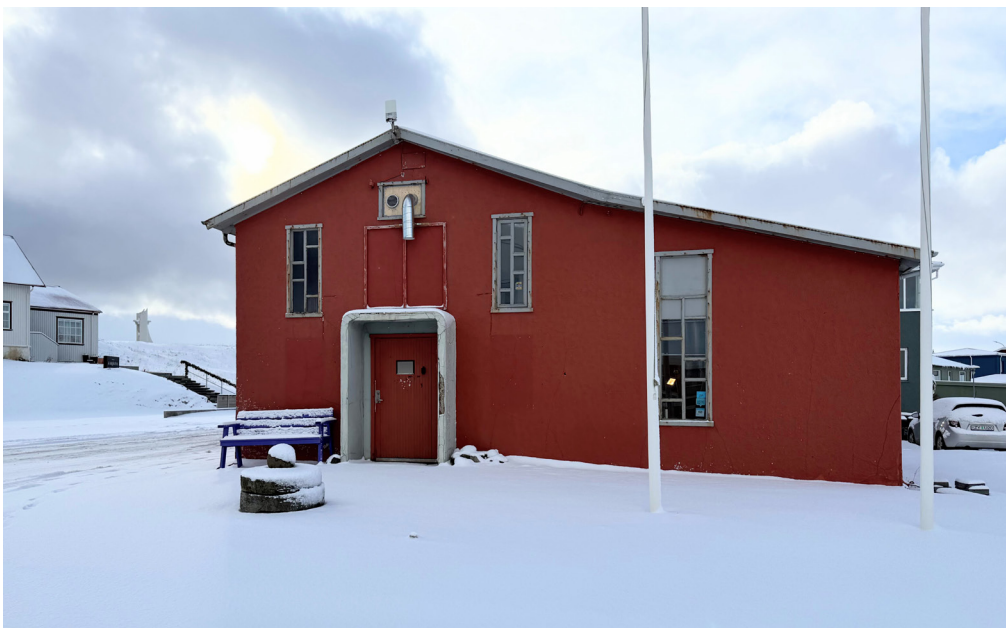
Unnið er nú að því að setja upp loftskiptakerfi í húsinu eins og sjá má framan á húsi.
