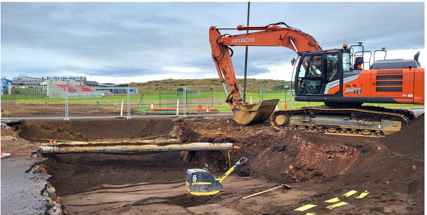
Umtalsverð framkvæmd var að endurnýja lögnina.
