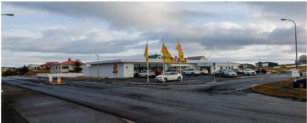
Mynd 3.23 Gangbrautir við gatnamót Aðalgötu og Borgarbrautar. Mynd tekin af Sumarliða Ásgeirssyni.
