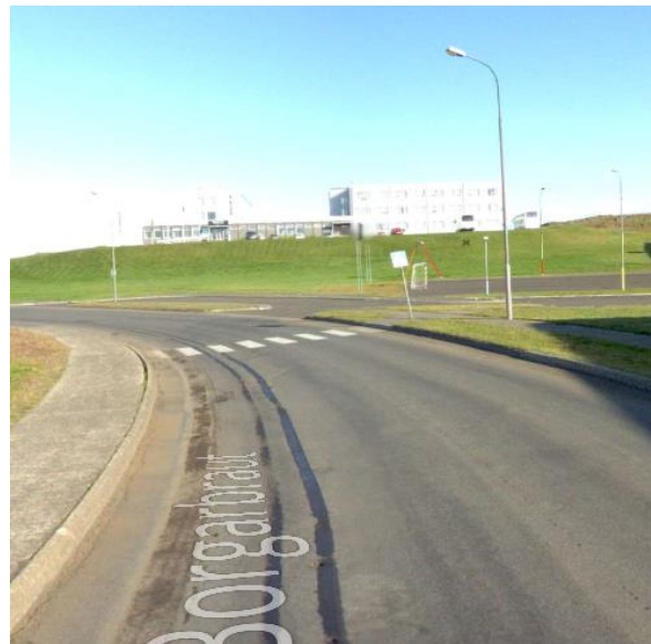
Mynd 3.25b Eldri mynd af gangbraut yfir Borgarbraut við Grunnskóla. Mynd tekin af ja.is.
