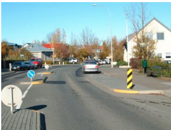
Mynd 3.17 Miðeyjar og þrængingar notaðar saman við biðstöð almenningsgangna í Reykjavík
