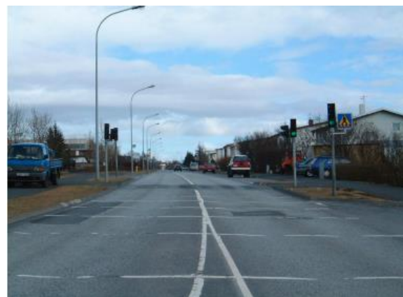
Mynd 3.18 Buldurspölur eru upphækkaðar línur sem liggja þvert á akstursstefnu. Þær hafa sjónræn, hljóðræn og titrandi áhrif á ökumenn.
