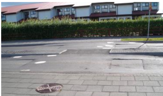
Mynd 3.11 Svokölluð H-Hraðahindrun eykur halla lengri bíla og auðveldar þar með akstur stórra ökutækja.
